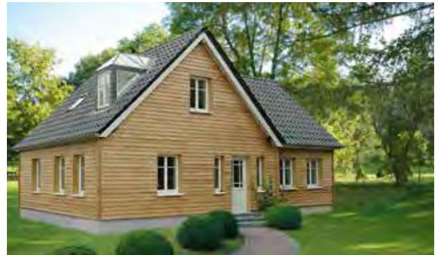
Fassaden-Gestaltung mit Fassadenprofil, Lärche naturbelassen
