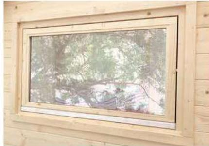
Fenster zum Öffnen, isolierverglast
