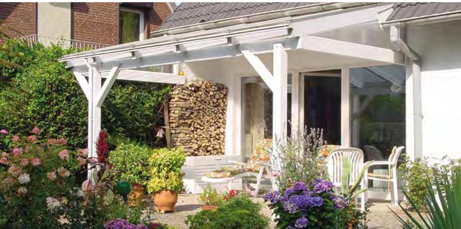
Sonderanfertigung, aufgrund geringer Traufhöhe bauseits mit Dachanschluss
