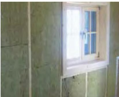
„Winterfest-Option“: doppelschalige Außenwand mit innenliegender Dämmung. **Aufpreis für doppelschalige Außenwände:** Verschiebesystem und ca. 18 mm Nut- und Federbretter inkl. Befestigungsmaterial und breiteren Tür- und Fensterfuttermaterial; geeignet für Einbringung von ca. 100 mm Dämmmaterial
