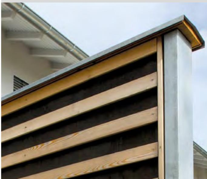
Ausführung mit Stahlpfosten
