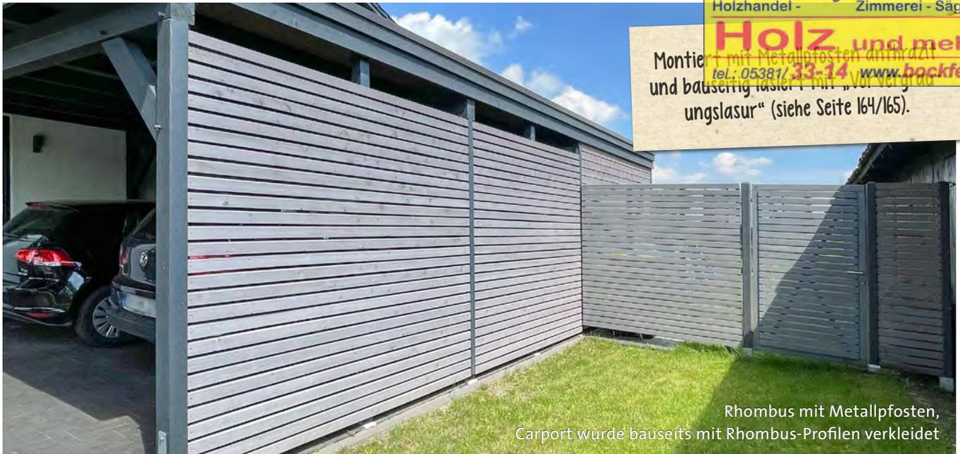
Rhombus mit Metallpfosten, Carport wurde bauseits mit Rhombus-Profilen verkleidet
