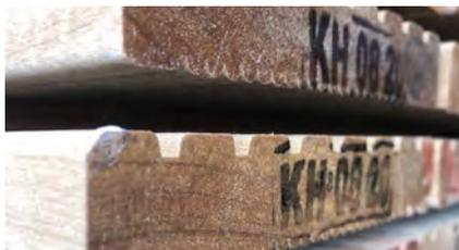
**Wachsschutz:** Um das Hirnholz vor eindringender Feuchte auf den langen Transportwegen zu schützen, wird ein Wachsfilm jeweils auf die Brettenden aufgetragen. Dieser ist vor der Verarbeitung mittels Kappschnitt zu entfernen, um Wachseinläufe in das Brett zu verhindern. Durch Wärmeeinwirkung würde das ansonsten passieren und ist optisch nicht schön. Wir empfehlen eine Nachbehandlung mit unserem Hirnholzschutz (keine Wachsbasis).
