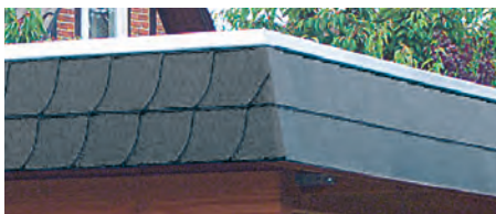
Walmblende, komplett mit zwei Reihen Schindeln 20 x 20 cm mit Bogenschnitt und Alu-Abdeckung Stucco blank 123 x 45 mm.
