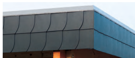
Senkrechte Schindelblende, komplett mit zwei Reihen Schindeln 20 x 20 cm mit Bogenschnitt und Alu-Abdeckung Stucco blank 123 x 45 mm.
