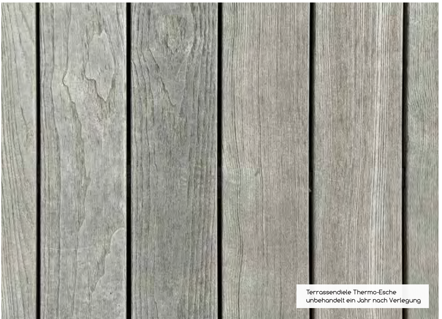
Terrassendiele Thermo-Esche direkt nach der Verlegung
