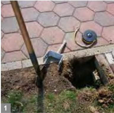
**1** Aller Anfang ist leicht: Prüfen Sie, ob betonierte Wegkanten die Arbeiten stören könnten. Wählen Sie danach die Bodenbefestigung.
