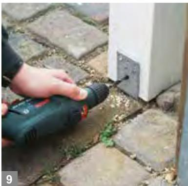
**9** Holzpfosten fixieren: Die Schraubenlöcher vorbohren, damit das Holz nicht reißt. Wir empfehlen 8 x 60 mm-Schrauben.
