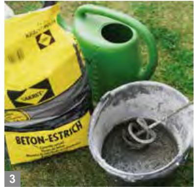
**3** Portionsweise für je ein Loch: Beton und Schnellbinder werden mit Rührgerät und Bohrmachine im Eimer gemischt.
