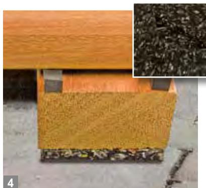
4 Gummi reguliert: Höhenausgleich-Pads für die Unterkonstruktion.
