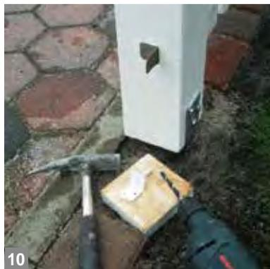
**10** Halt für die Elemente: Löcher für die L-Beschläge vorbohren. Beschläge mit leichten Hammerschlägen etwa 1 cm tief einschlagen, dann erst eindrehen.
