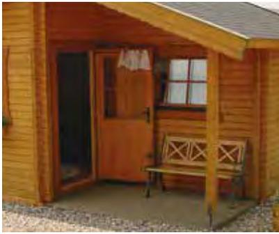
Zurückversetzter Eingang mit Überdachung
