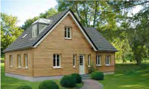
Fassaden-Gestaltung mit Fassadenprofil, Lärche naturbelassen
