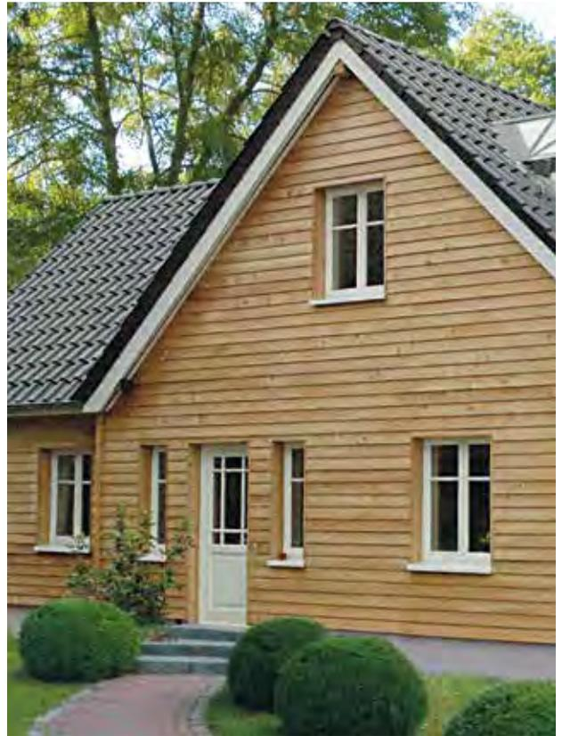
Fassadengestaltung mit Fassadenprofil, Lärche naturbelassen
