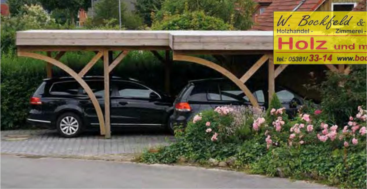
Als bewährte praktische Alternative zum herkömmlichen Pfosten bei engen Einfahrtsituationen. Pfostenbogen an einem Winkelcarport (Sondermodell). Inkl. verstärkter Konstruktion/geänderter Pfostenabstände. Lieferbar für Standard-Durchfahrtshöhe von 210 cm.
