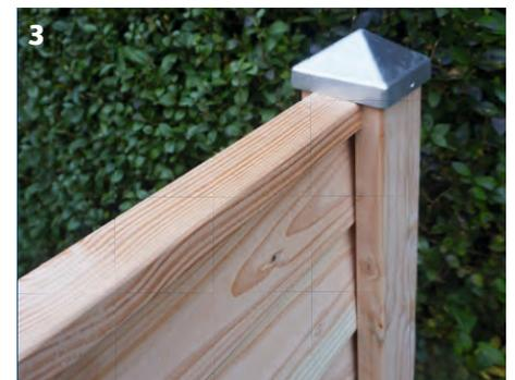
**1.** Die Zaunpfosten werden im Abstand von 197 cm (lichte Weite) gesetzt. Dabei müssen die Laschen der Pfostenanker nach vorne und hinten zeigen. Die Jütland-Bretter schieben Sie in die Nuten der Pfosten. Hierbei ist die dünne Seite nach oben gerichtet (Wasserablauf). Das unterste Brett sollte ca. 3 cm von der Pfostenunterkante beginnen.
