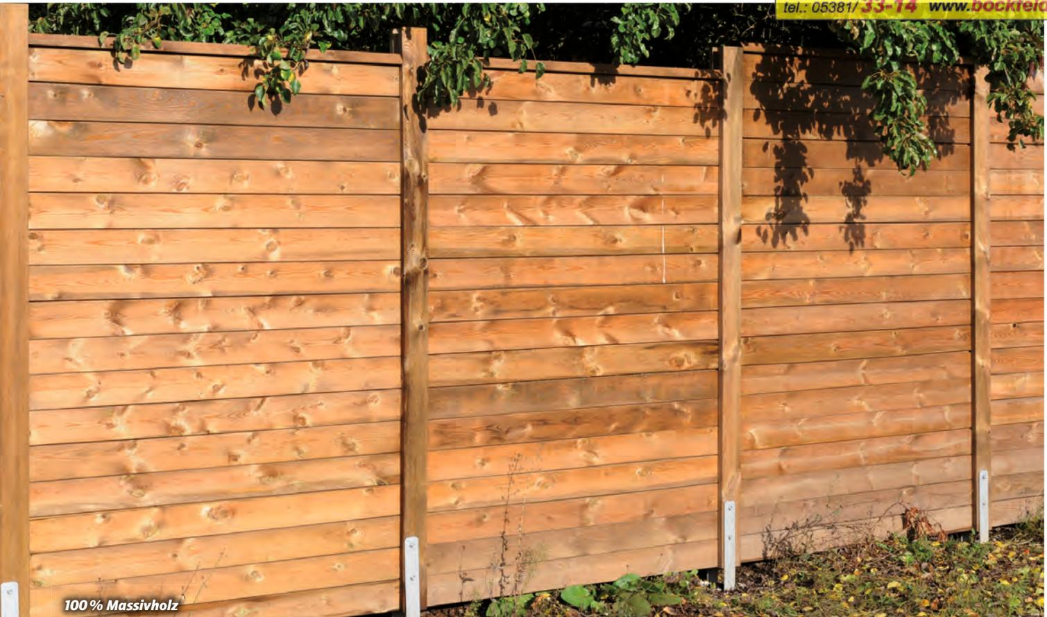
Durch immer dichtere Bebauung und zunehmenden Straßenverkehr wird Lärm zu einem spürbaren Problem. Eine deutliche Lärminderung erreichen Sie mit unserem Spezialzaun Massiv. Ein kompaktes System aus Pfosten 11 x 11 cm und waagerechten
