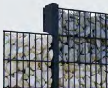
Steinmauer mit feuerverzinkten und pulverbeschichteten Pfosten (Anthrazit)
