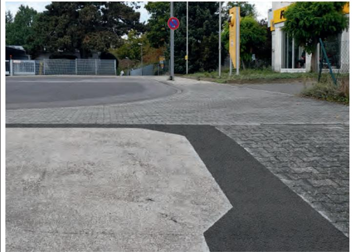
Komplettes Bodenreparatur-Set für kleinere Ausbesserungen schadhafter Stellen.
