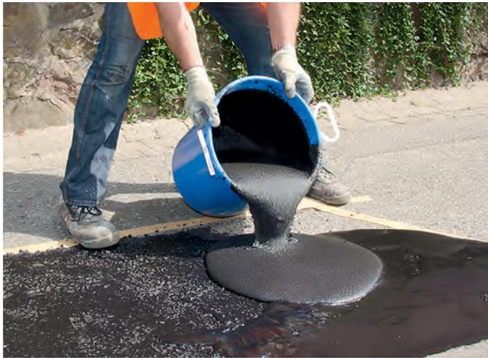
Ein Reparaturgemisch für drei verschiedene Untergründe: Beton, (Guss-)Asphalt, Estrich
