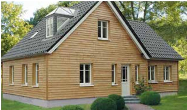
Fassaden-Gestaltung mit Fassadenprofil, Lärche naturbelassen
