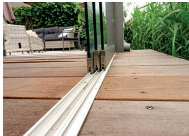
Glasaufnahme der Führungsschiene max. 5 Scheiben.
