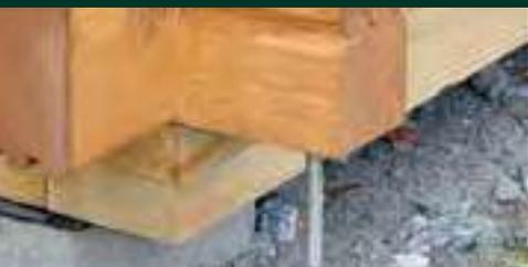
Optimale Auflage der Dachbretter durch abgeschrägte Seitenwandbohle
