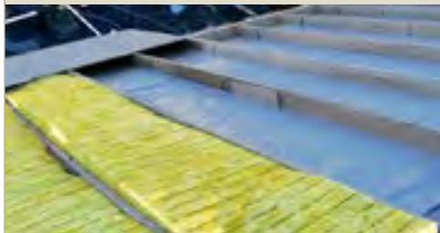
Optimale Auflage der Dachbretter durch abgeschrägte Seitenwandbohle
