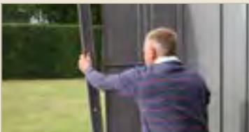
Anbringen/Verschrauben der rechten Rückwand mit der Verbindungsleiste.
