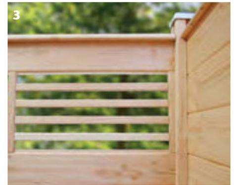
**3.** Der Gittereinsatz (optional) wird ebenfalls in die Nut geschoben. Drehen Sie das oberste Brett um, sodass die Feder nach unten zeigt und in die Nuten der Gitterleisten fasst. Hier wird beim obersten Brett nicht die Feder, sondern die Nut mit einem 2 cm breiten Streifen längs abgeschnitten. Die Pfostenköpfe werden mit einer Kappe geschützt.
