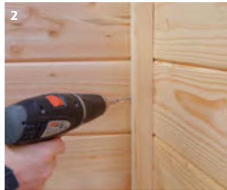
**2.** Fixieren Sie jedes Brett mittig mit einer Schraube von 3,2 x 40 mm. Diese werden seitlich schräg in die Nut geschraubt. Beim obersten Brett muss die Feder in einem Streifen von 2 cm abgeschnitten werden. Darauf kommt die Abdeckleiste. Diese ist mit 178,5 cm etwas länger. Einfach maßgerecht anpassen und von oben festschrauben (vorbohren).
