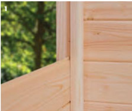
**1.** Die Zaunpfosten werden im Abstand von 177 cm (lichte Weite) gesetzt. Dabei müssen die Laschen der Pfostenanker nach vorne und hinten zeigen. Die Steckzaun-Bretter schieben Sie in die Nuten der Pfosten. Hierbei ist die Feder des Brettes nach oben gerichtet (Wasserablauf). Das unterste Brett sollte ca. 3 cm von der Pfostenunterkante beginnen.
