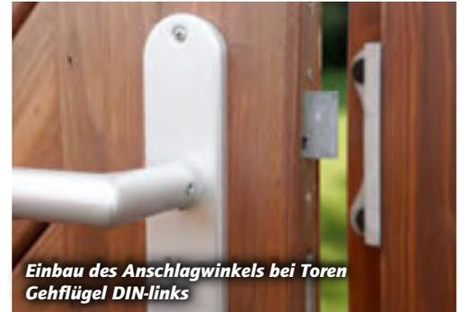
Einbau des Anschlagwinkels bei Toren
