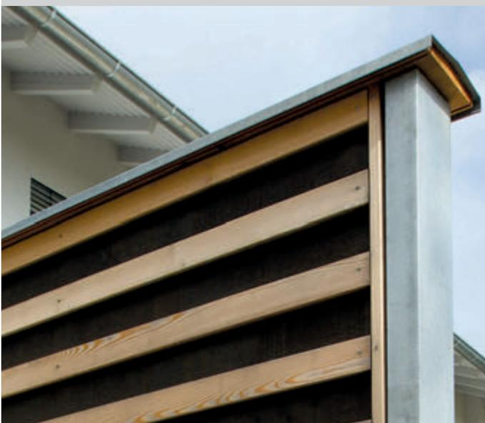
Ausführung mit Stahlpfosten
