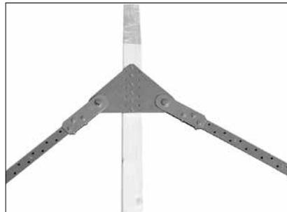
Detail am First: Bandanschluss BK25 mit Kopplungsverbinder BK25 nur in der mittleren Lochreihe ausgenagelt.
