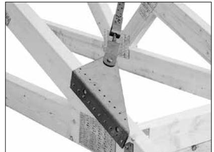
Detail am Traufpunkt: Bandanschluss BNG25 mit Spanngerät BNSP25 seitlich am Sparren mit Nägeln befestigt.
