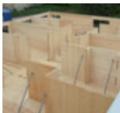
BBS Wandelemente erfüllen sicher und solide alle Anforderungen der Statik, der Aussteifung, des Brandschutzes sowie der Bauphysik. BBS Konstruktionen erreichen alle üblichen sowie dem Stand der Technik entsprechenden Wärmedämmwerte und führen aufgrund des diffusionsoffenen Aufbaues und der Eigenschaft, Spitzenwerte der Raumluftfeuchte dämpfen zu können, zu einem behaglichen und ausgeglichenen Raumklima.
