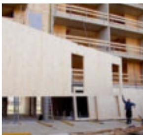
Mittels CNC gesteuerten Abbundanlagen können die Elemente individuell bearbeitet werden. Die Maßtoleranz liegt bei  $\pm 1$  mm. Selbst komplexe Bearbeitungen wie Stahlträgerausfräsungen oder beidseitige Bearbeitungen, Deckendurchbrüche, Bohrungen, Nutfräsungen usw. sind mit den modernen CNC Abbundanlagen möglich.
