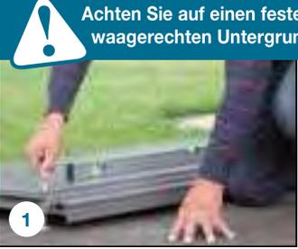
**1** Bodenplatte mittels Stellfüßen in waage bringen.
