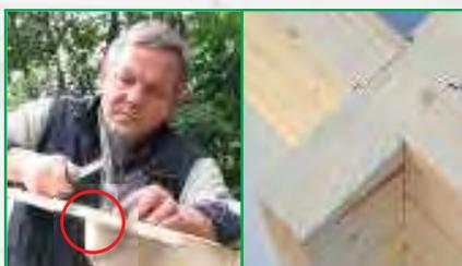
Optimale Auflage der Dachbretter durch abgeschrägte Seitenwandbohle
