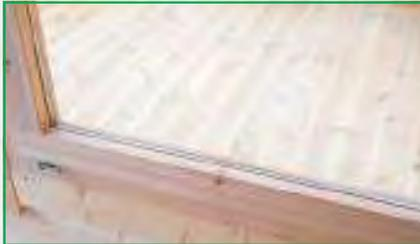
Isolierverglasung bei 44 mm Modellen
