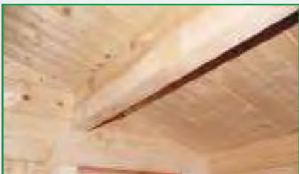
Stabile Dachpfetten; Dachbelastbarkeit über 180 kg/m<sup>2</sup>
