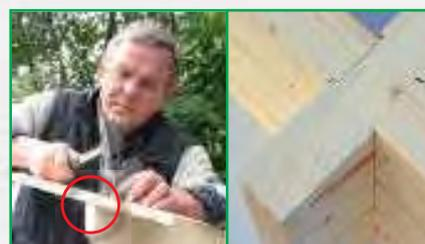
Optimale Auflage der Dachbretter durch abgeschrägte Seitenwandbohle
