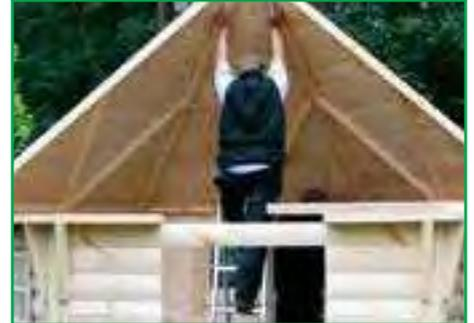
Vorgefertigte fertig geschindelnde Dachelemente für eine passgenaue Montage
