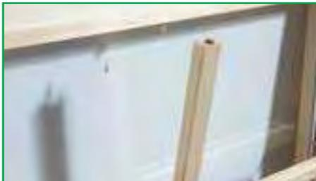
Clips zum einfachen Lösen und entfernen der Sprossen
