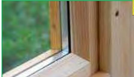
Isoverglaste Leimholz-Fenster mit Dichtung zum Schutz vor Kälte
