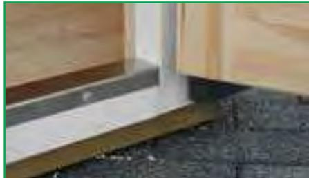
Isolierverglaste Leimholz-Türen mit verzinkter Türschwelle und Dichtung
