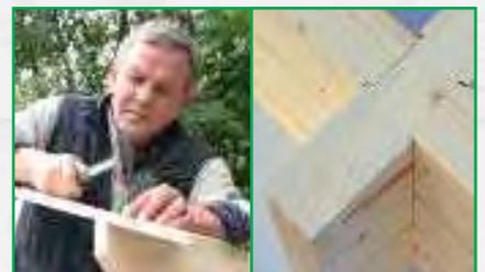
Optimale Auflage der Dachbretter durch abgeschrägte Seitenwandbohle
